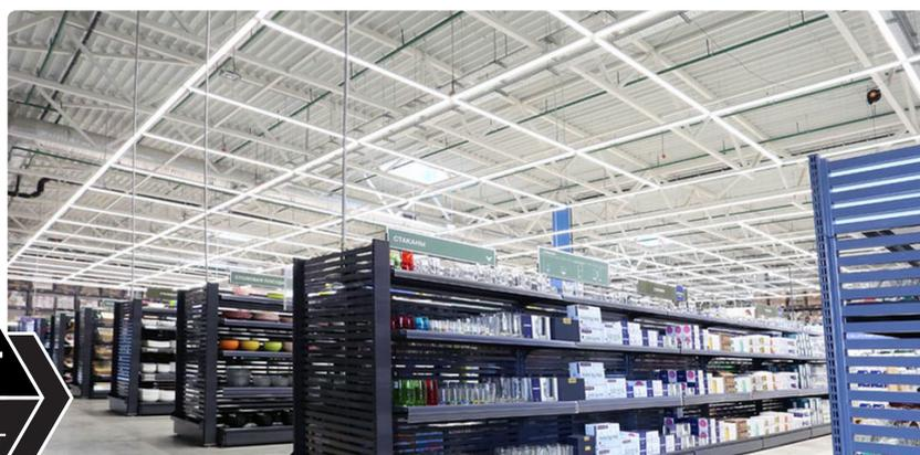
Светодиодные пылевлагозащищенные светильники Navigator серии DSO-01-LED-A (аналог LCO) предназначены для освещения торговых пространств и коммерческих помещений, в том числе оснащенных системой пожаротушения. Внутри светильников реализована сквозная проводка, соединительная крышка позволяет подключать светильники в герметичную линию без видимых проводов.
